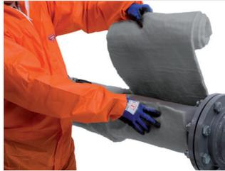
Abbildung 24: Achten Sie beim Aufbringen mehrerer Schichten darauf, dass der Ausgangspunkt der Dämmung mit der Rohrachse übereinstimmt.
