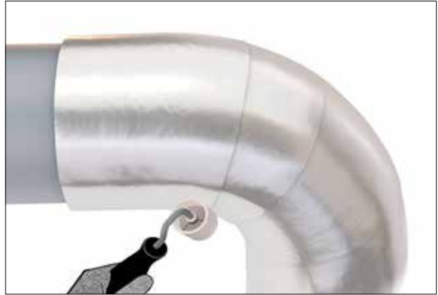
Abbildung 69: Überlappungen mit der Rolle fixieren
