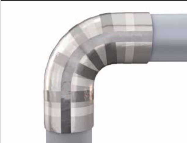
Abbildung 20: Komplett angebrachtes Dampfsperrenband
