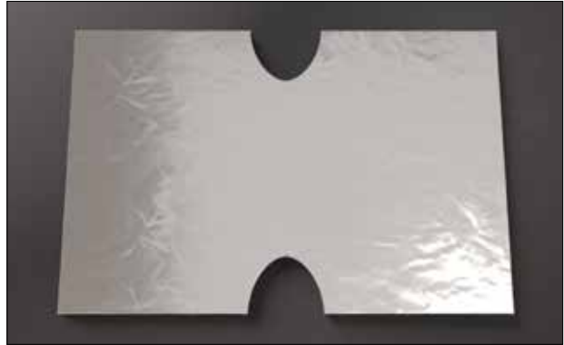
Abbildung 22: Dämmung für symmetrisches T-Stück anfertigen
