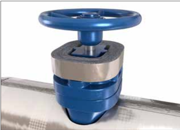
Abbildung 47: Hohlraum um die Spindel auffüllen
