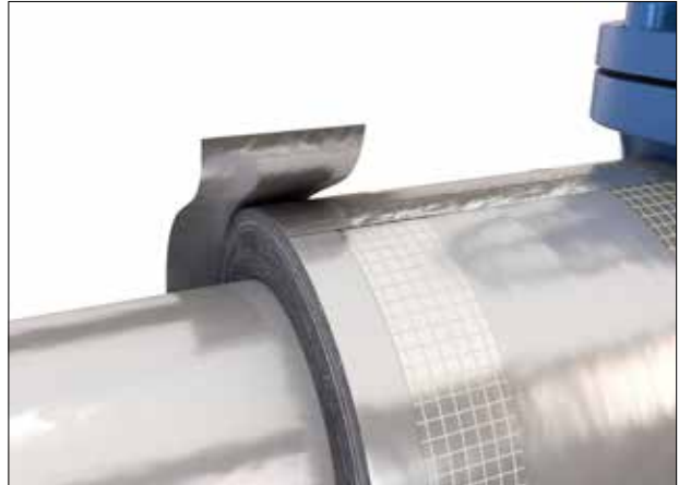
Abbildung 43: Dampfsperrenband am Abschluss der Dämmung anbringen
