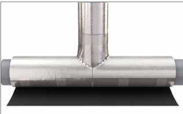
Abbildung 72: Primäre Dampfsperre am symmetrischen T-Stück anbringen
