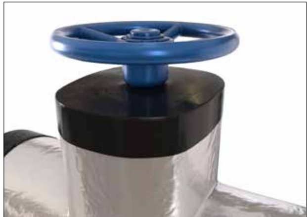
Abbildung 55: Dampfsperre an der Ventilspindel auftragen
