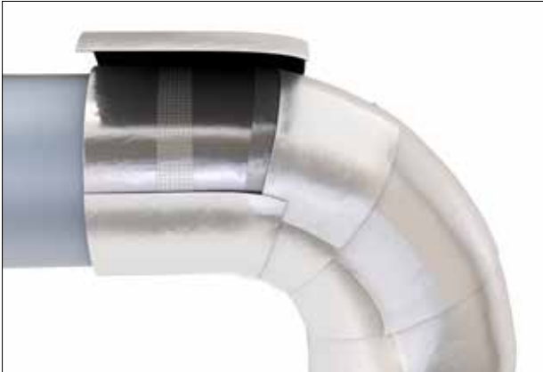
Abbildung 68: Das letzte Segment der primären Dampfsperre anbringen
