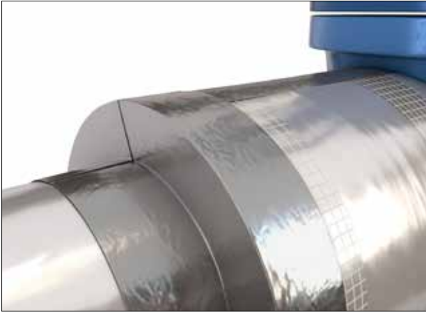
Abbildung 46: Vollständig abgedichteter Abschluss der Dämmung
