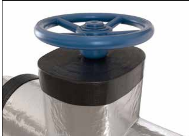
Abbildung 57: Dampfsperre auf dem Abschluss der Spindeldämmung auftragen
