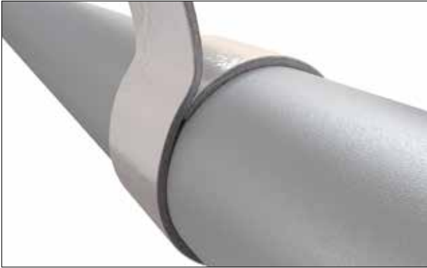
Abbildung 7: Umfang der Rohrleitung ermitteln
