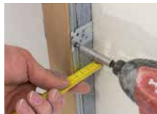
7. Montageprofile befestigen
