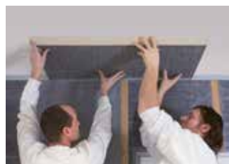
10. Dämmkeil mit Randabschluss- profil an Decke / Wand anbringen
