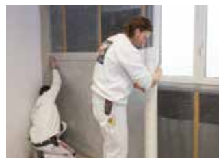
11. Luftdichte Ebene herstellen
