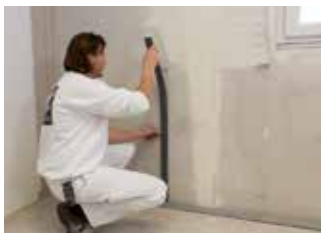
5. Dämmstreifen einlegen
