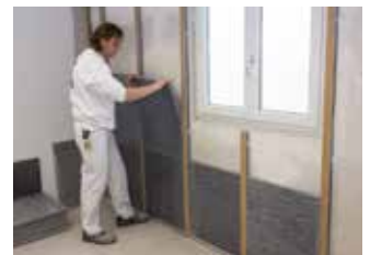
8. Dämmstoff einpassen
