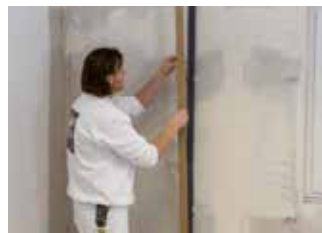
6. Montageprofile einfügen
