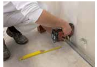
4. Entkopplungsstreifen auslegen und Bodenprofil montieren
