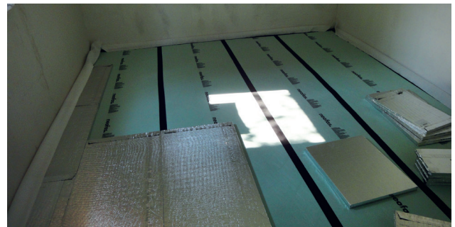
Grünes Vlies verlegen, Stöße verkleben. Vakutherm abdecken mit grünem Vlies und abkleben.
