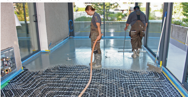
Der Anhydrit wird eingebracht.
