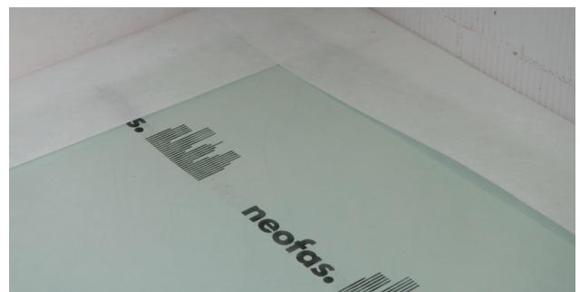
Brandschutzvlies auf das weisse Vlies legen.
