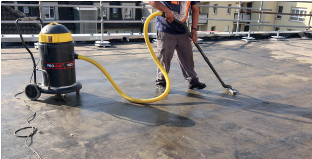
Der Boden muss vorab gesaugt ...
