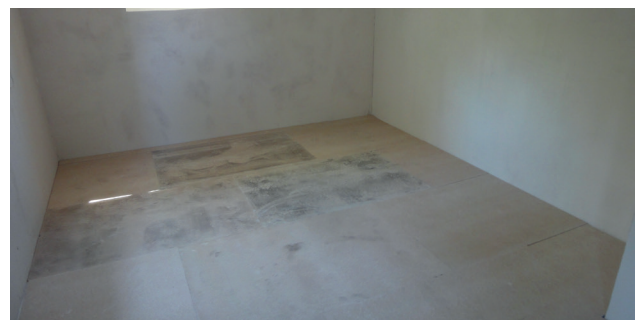
1. Lage Rigidur verlegen (keine Kreuzfugen).
