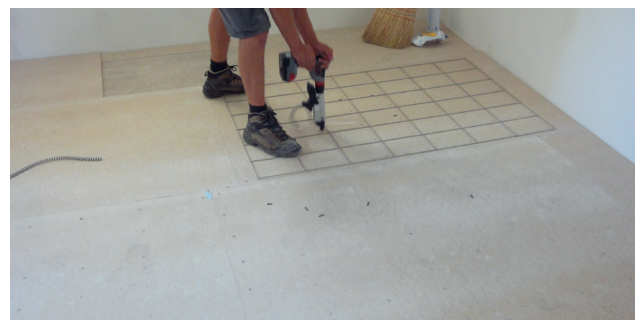
2. Lage verschrauben (mit Raster), überschüssigen Leim abstossen, vorstehende Schrauben versenken.
