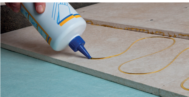
2. Lage Rigidur verlegen und mit der 1. Lage verkleben (Stösse versetzen).
