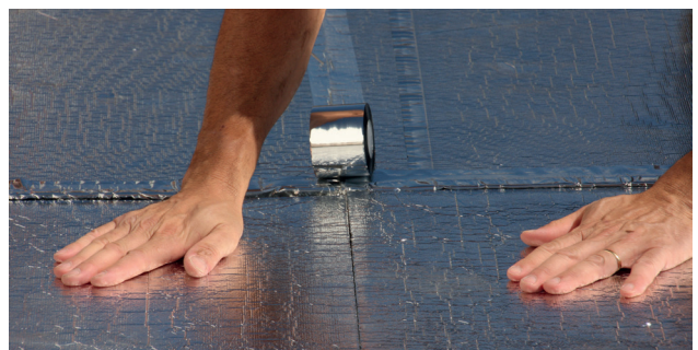
Alle Plattenstösse müssen mit unserem Klebeband verklebt werden.
