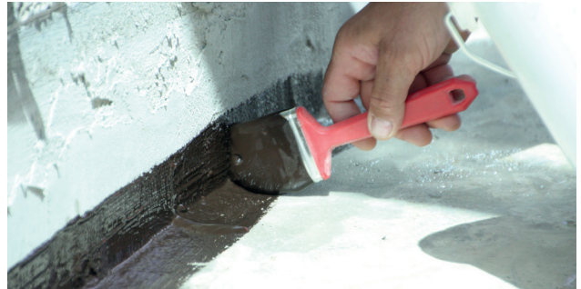
Alle Wand- / Bodenanschlüsse werden mit ISO-Sealtec HBB eingestrichen, um eine gute Abdichtung zu gewährleisten.
