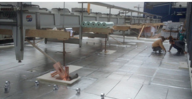
Vakutherm zueinander schieben und verkleben.
