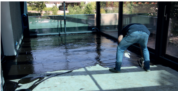
Zur Abdichtung der ganzen Fläche wird diese mit ISO-Sealtec HBB beschichtet.
