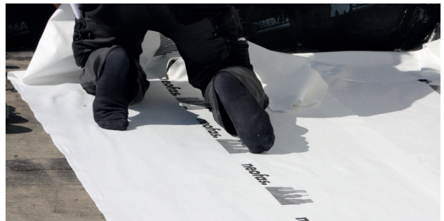
Das weisse Vlies wird verlegt und an der Wand hochgezogen.
