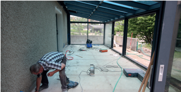
Der Boden muss vorab von Unebenheiten befreit werden.
