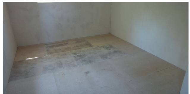
1. Lage Rigidur verlegen (keine Kreuzfugen).
