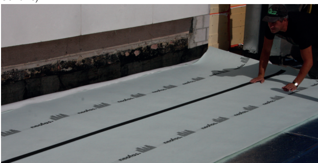
Als zweite Schutzlage wird das grüne Schutzvlies verlegt.
