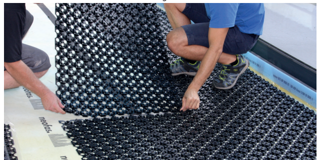
Auf das fertig verlegte Vlies wird das Uponor-Minitec-System geklebt.
