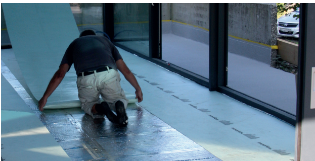
Auf die Vakutherm wird ein einseitig klebendes grünes Vlies verlegt. Die Vliesstöße mit schwarzen Klebeband verklebt.
