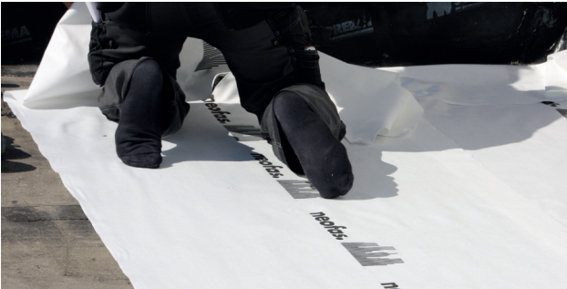
Weisses Vlies verlegen und hochziehen.
