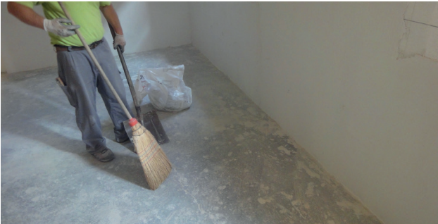
Boden reinigen und trocknen.
