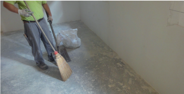
Boden reinigen und trocknen.
