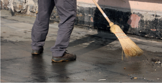
Boden reinigen und trocknen.
